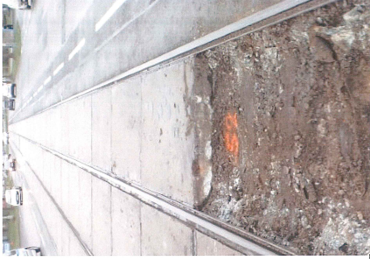
Foto č. 8 – Detail sondy S2 (mezi prážci)
